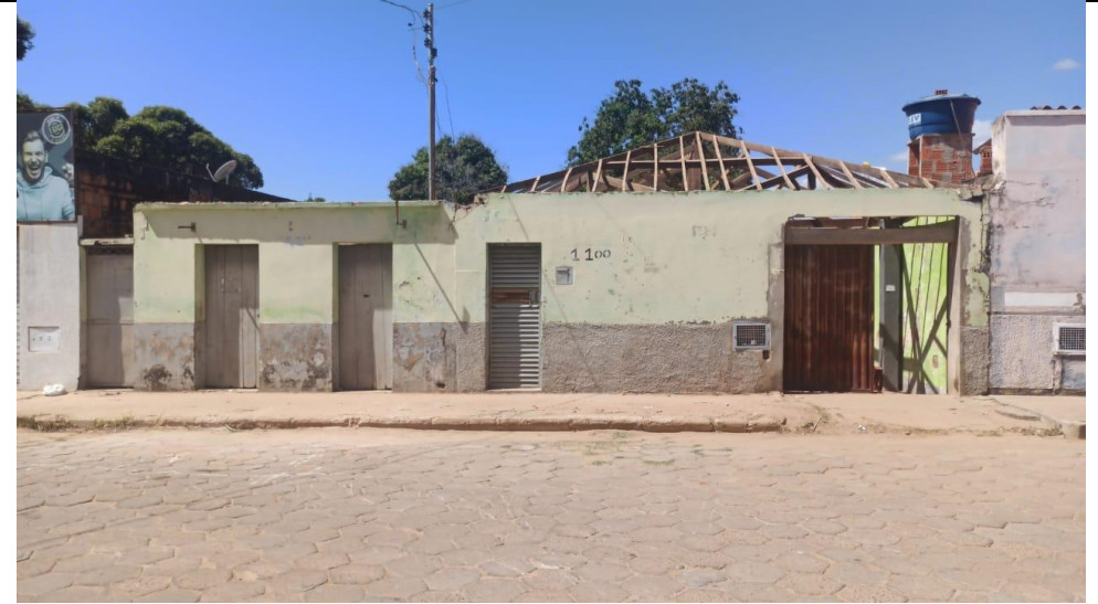
Foto 04 – Local para construção do Espaço Multiuso E.E. Pres. Olegário Maciel Data: 03/08/2022 – Vista frontal
