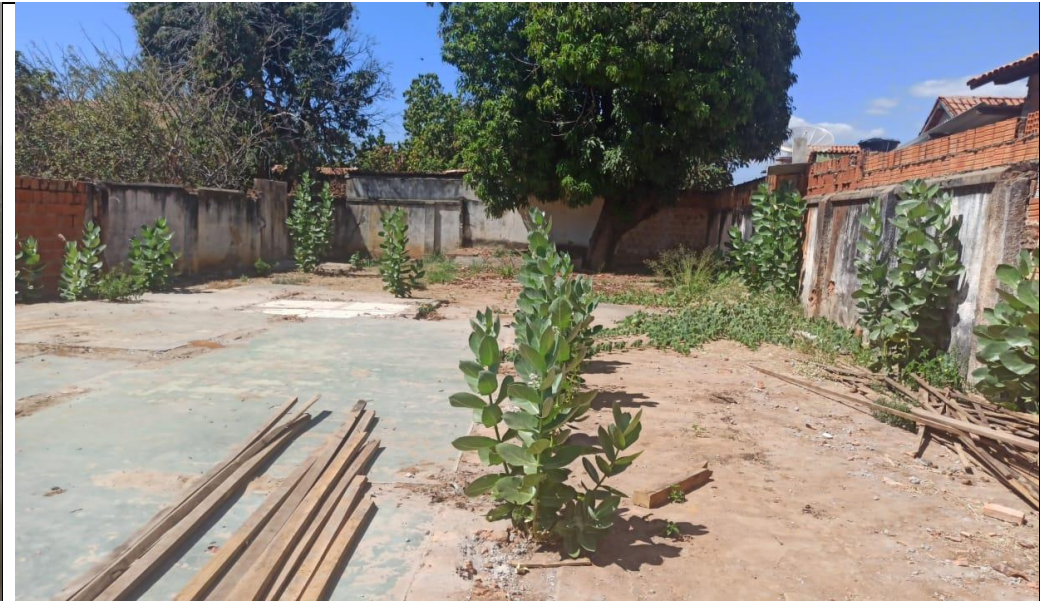
Foto 02 – Local para construção do Espaço Multiuso E.E. Pres. Olegário Maciel Data: 03/08/2022 – Vista geral
